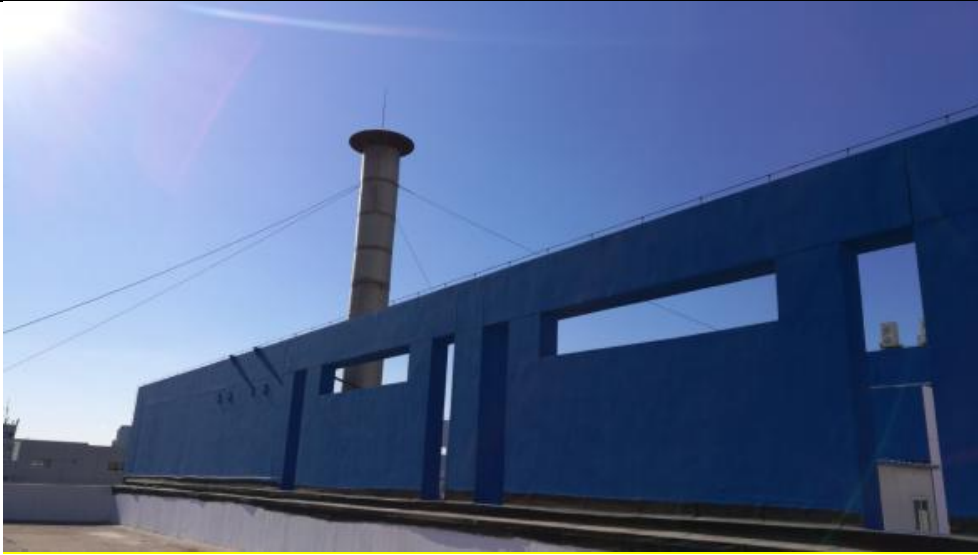
附图 4 轮转机烘干设备排气筒
